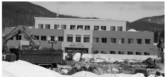
新しいからまつ園施設（写真手前：旧施設取り壊し）
