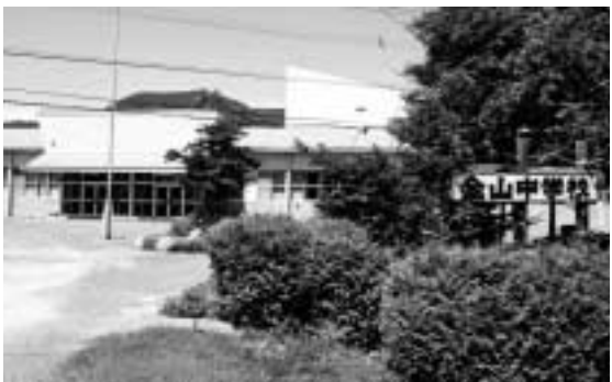
活用方法が検討されている旧金山中学校校舎
