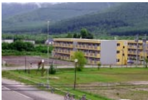
3棟目の3階建公営住宅が建設される幾寅西町
